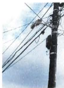
Retiro de cámara
