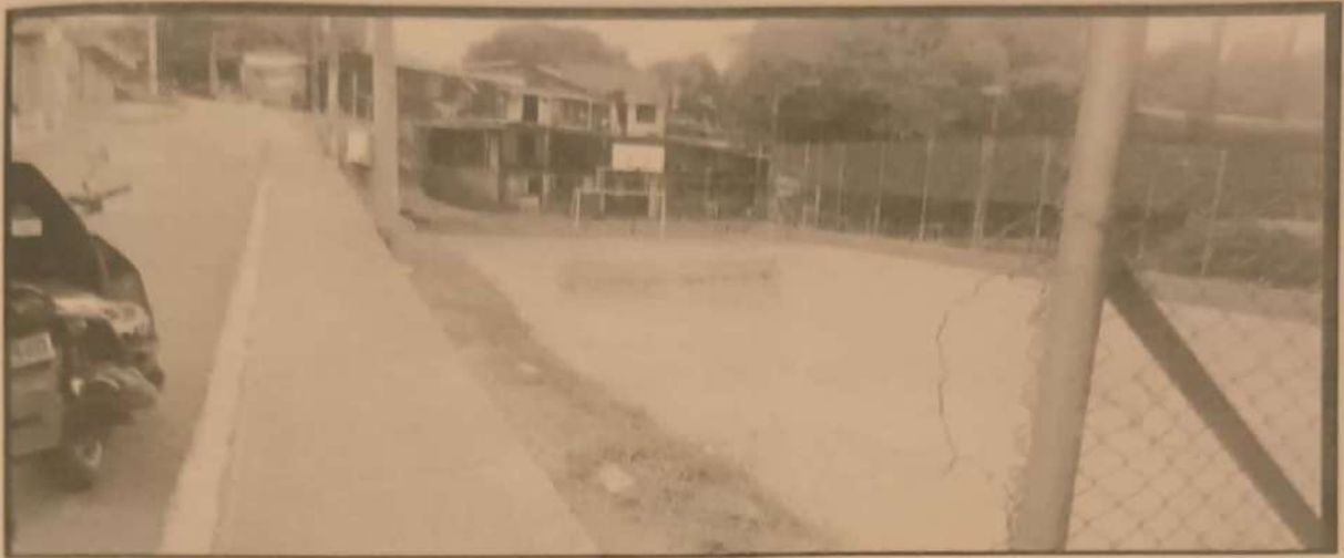
25 DE MAYO 35 MTS CERRAMIENTO CANCHA DE FUTBOLL
