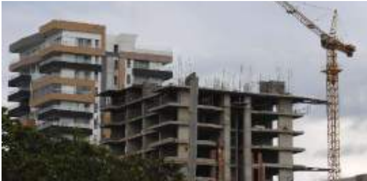
Foto 8. Sector de la Construcción en Armenia con Alto Crecimiento en los Últimos Años.
